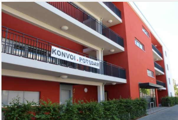
Wohnungsneubau Wohnprojekt Konvoi
