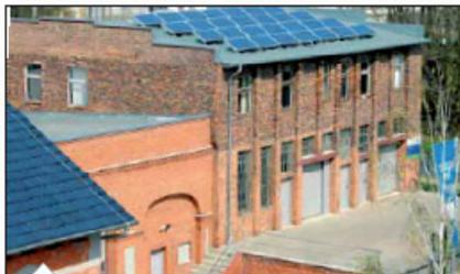
Seit Juni 2005 betreiben die Stadtwerke auf dem Dach des Hauses 3 (Foto) auf ihrem Firmengelände Freyschmidstraße eine Photovoltaik-Anlage. Mit 28 Modulen produzierte die Anlage auf knapp 40 m<sup>2</sup> innerhalb eines Jahres mehr als 5.000 kWh elektrische Energie. Photovoltaik-Anlagen werden in Deutschland gefördert. Jede in das Energienetz eingespeiste kWh wird mit 54,53 Cent vergütet.
